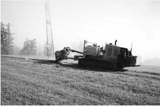
Grabfräse für die Verlegung der Quellwasser-Leitungen
