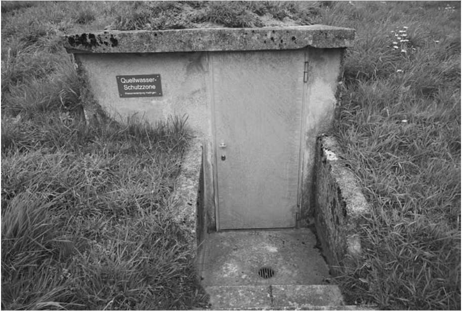
Brunnenstube Katzenrücken (Baujahr 1927) auf Gemeindegebiet Arni
